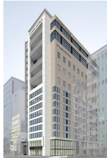
広島八丁堀 NKビル
